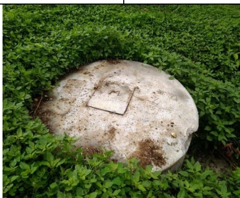
Figura 3.16 – Fossa central estanque da instalação.
