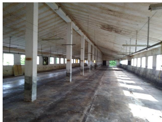
Figura 3.2 – Vista do interior de um dos pavilhões de recria – galinhas no solo que será alvo de remodelação.
