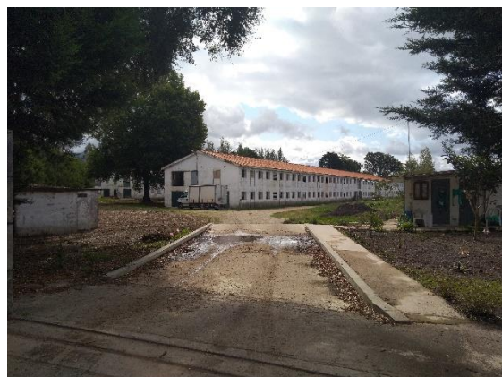
Figura 3.1 – Vista do exterior de um dos pavilhões de recria e rodiluvio à entrada da instalação.
