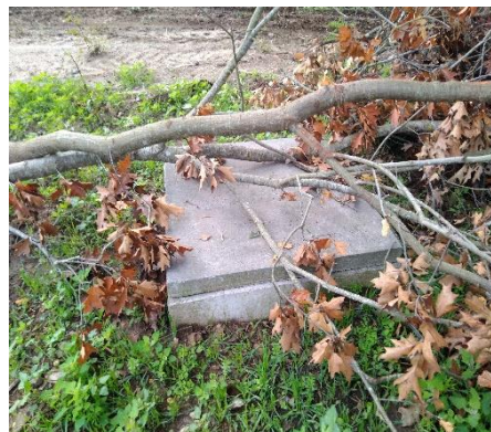
Figura 3.15 – Caixa de receção dos chorumes provenientes do Pavilhão C.
